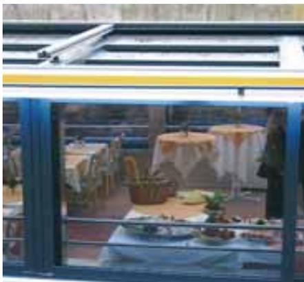
Zu 2/3 lassen sich die Dach- und Seitenfensterelemente der 12m langen Glasfront öffnen
