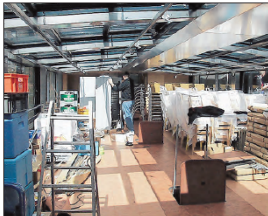
Mit letzten Ausrüstungsarbeiten wurden vor einigen Tagen die Schiffe starkklar gemacht.
