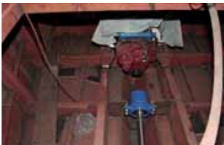
Blick in den Maschinerium der „neuen Siebnerin“
