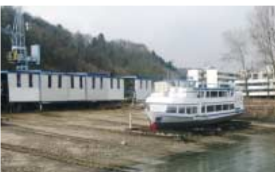
Blick auf die Helling mit verschiebbarer Schiffbauhalle. Um auch längere Fahrzeuge bauen und reparieren zu können soll die Helling verlängert werden Bild: Guddat
